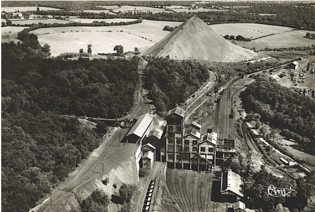
Terril, ateliers de tri et de lavage du Pré-Charpin.
